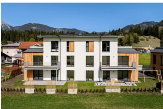
Außenansicht Haus A
