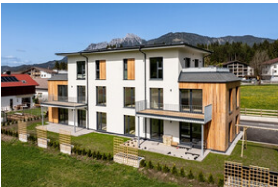
Außenansicht Haus A
