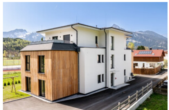
Außenansicht Haus A
