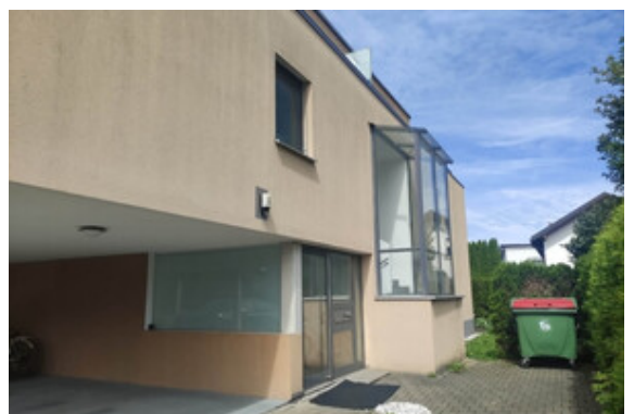
Eingang ins Stiegenhaus
