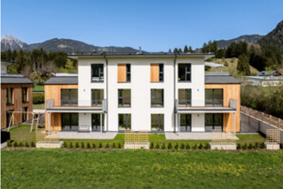
Außenansicht Haus B
