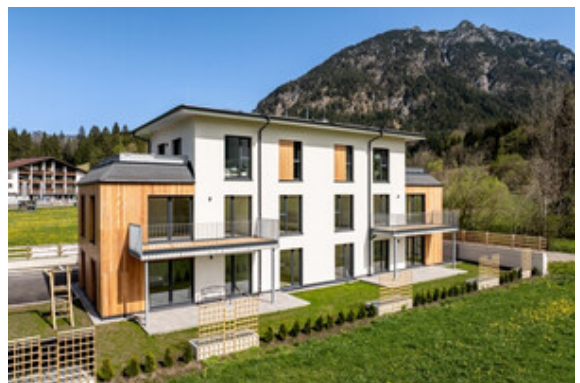
Außenansicht Haus B
