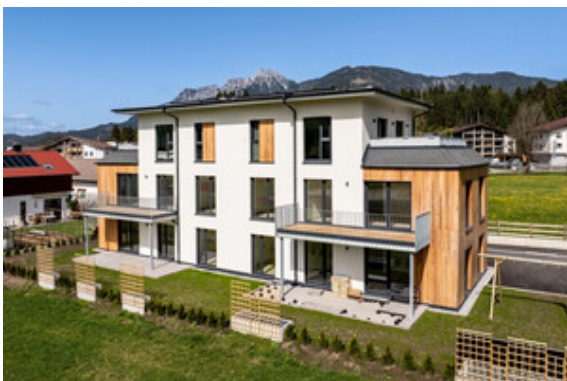
Außenansicht Haus A
