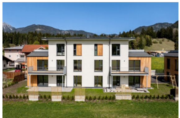
Außenansicht Haus A
