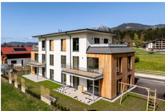
Außenansicht Haus A
