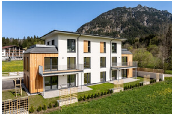
Außenansicht Haus B
