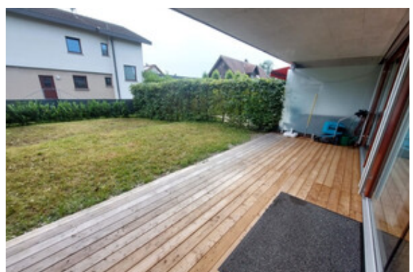
Terrasse mit neuem Lärchenholzrost
