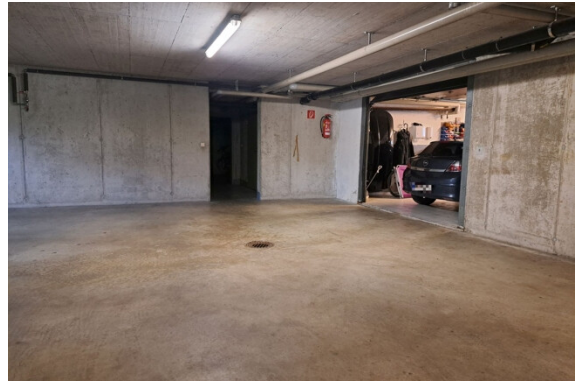
Eigene Garage in der Tiefgarage
