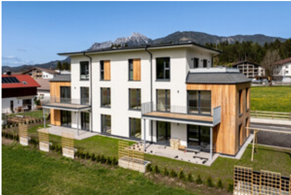
Außenansicht Haus A
