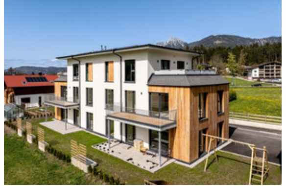
Außenansicht Haus A
