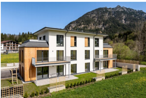
Außenansicht Haus B
