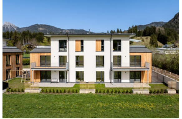
Außenansicht Haus B
