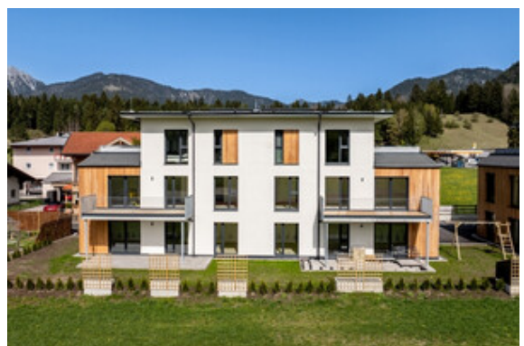
Außenansicht Haus A
