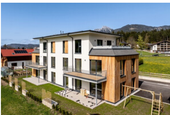
Außenansicht Haus A
