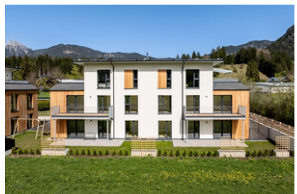
Außenansicht Haus B
