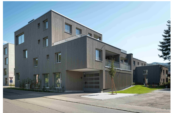
Außenansicht | TG Einfahrt
