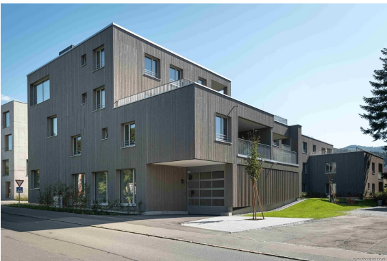
Außenansicht | TG Einfahrt
