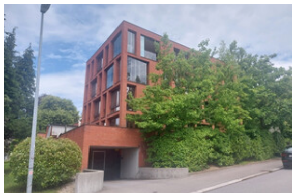
Außenansicht / TG Einfahrt
