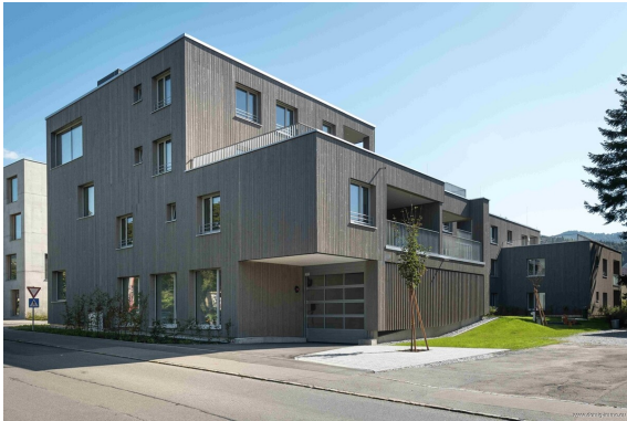
Außenansicht | TG Einfahrt
