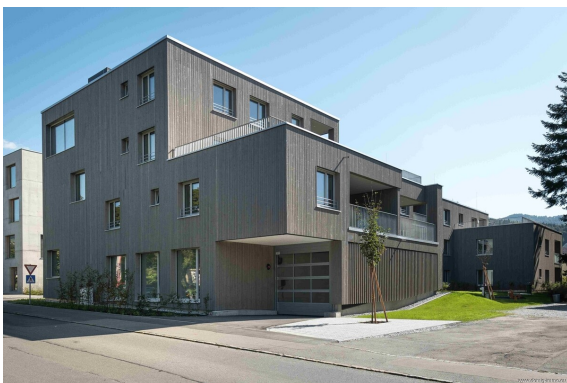
Außenansicht | TG Einfahrt
