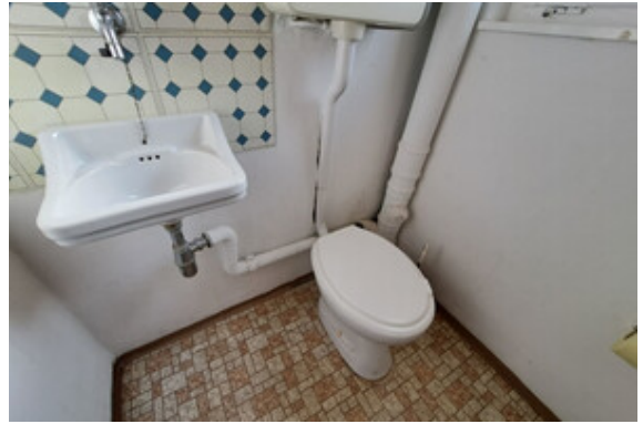
WC im Erdgeschoss
