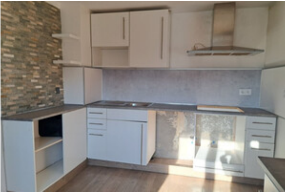
Küche im Erdgeschoss
