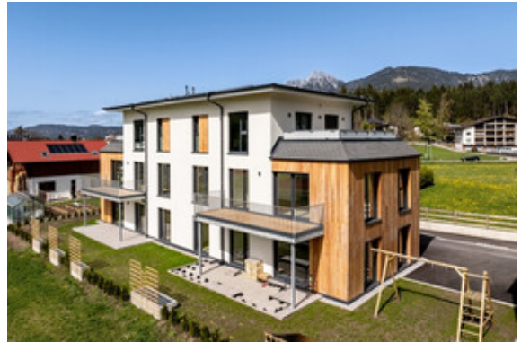
Außenansicht Haus A
