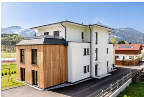
Außenansicht Haus A
