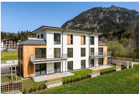
Außenansicht Haus B
