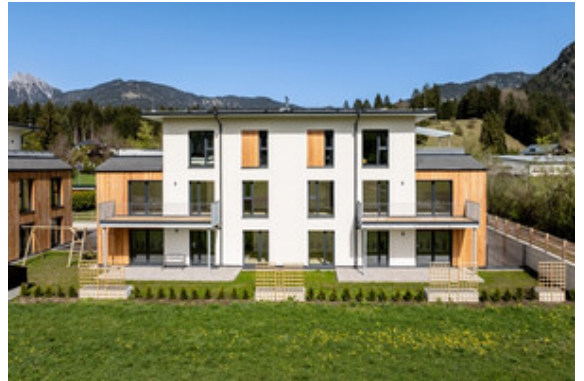
Außenansicht Haus B
