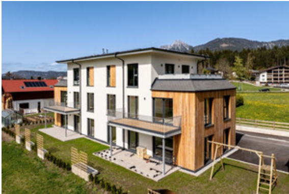
Außenansicht Haus A
