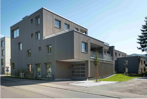
Außenansicht | TG Einfahrt
