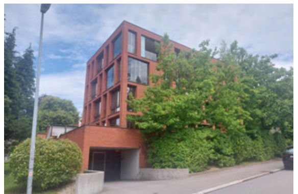
Außenansicht / TG Einfahrt
