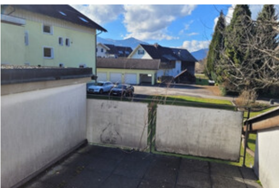
Terrasse im OG
