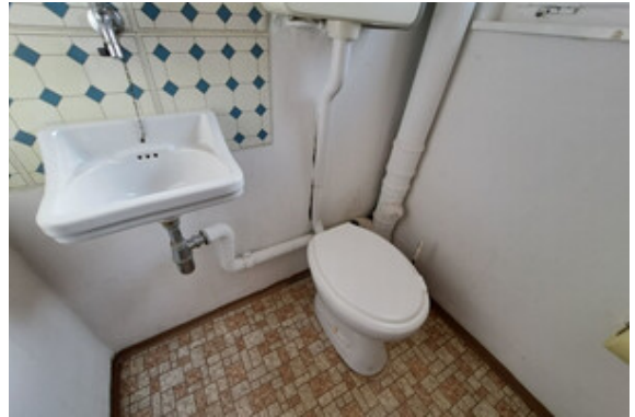
WC im Erdgeschoss
